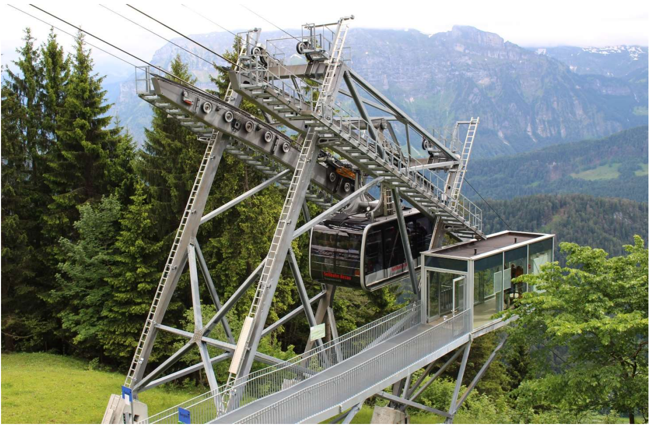
Stazione intermedia con cabina
