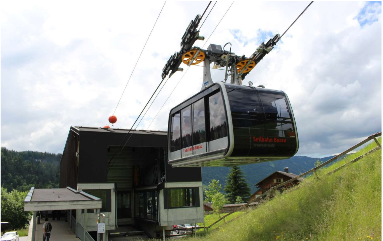
La stazione a valle con la cabina
