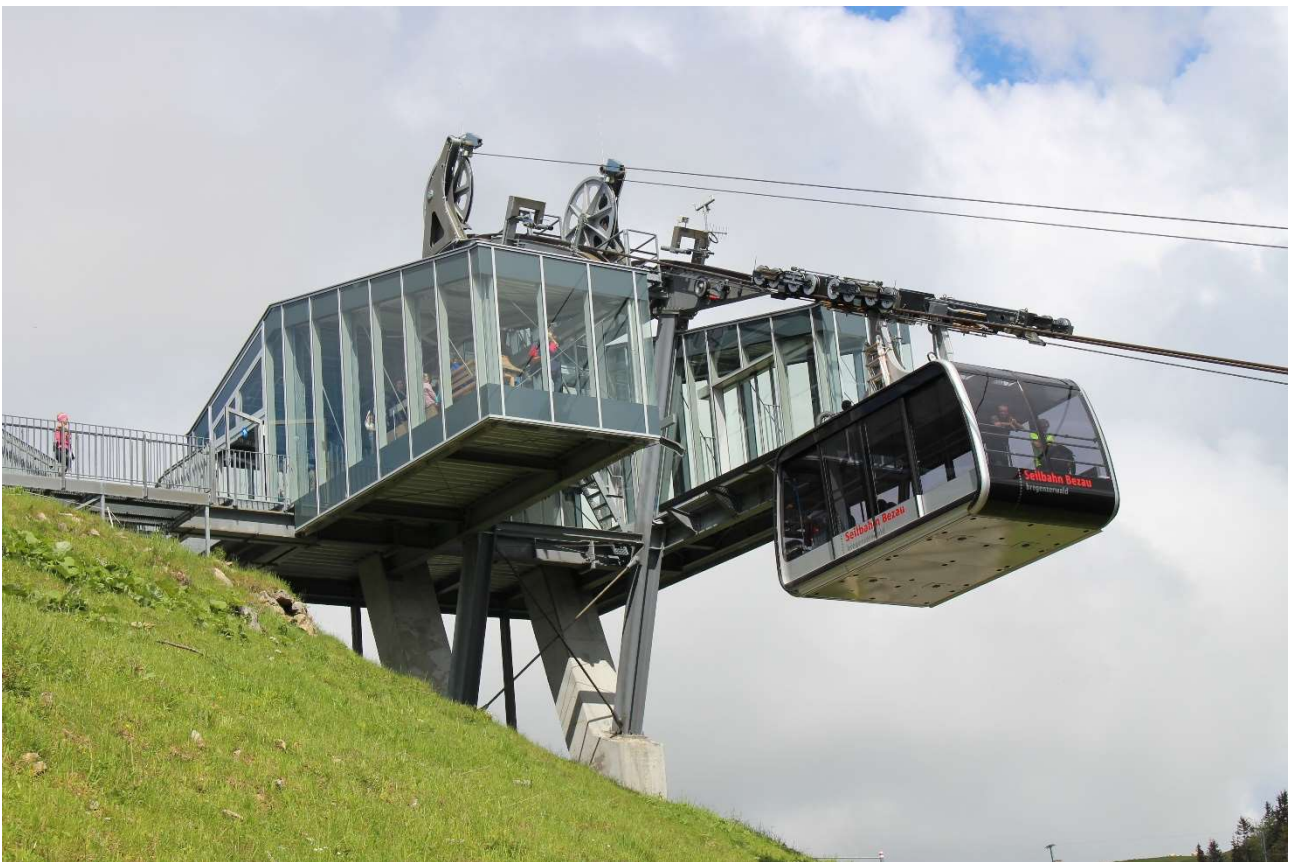
Stazione a monte con cabina in entrata
