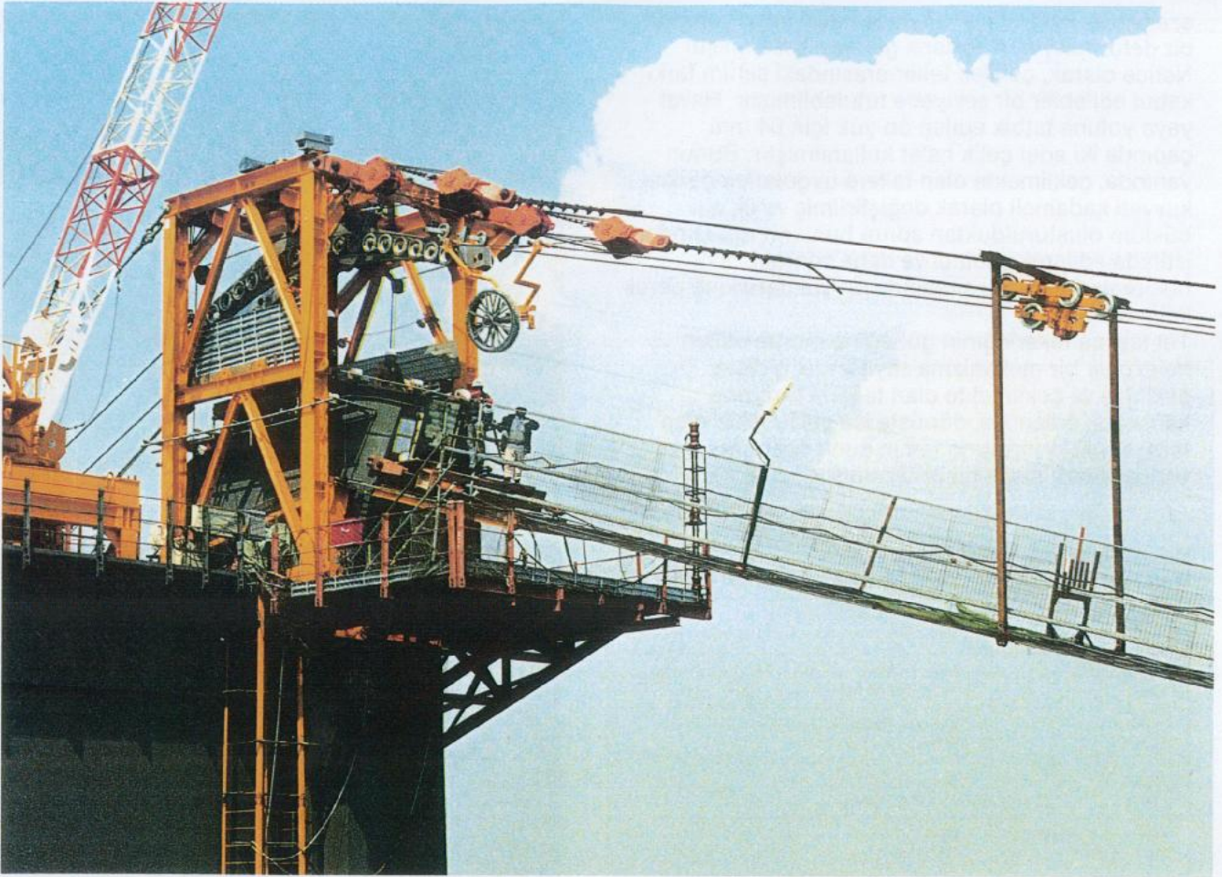
Spinning wheel at the tower top Tel taşıma tekerleği kule tepesinde
