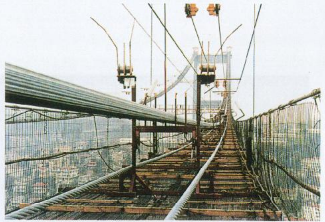
Cable former and preloaded ropes Kablo formunu veren aparat ve ön yük olarak konulmuş halatar
