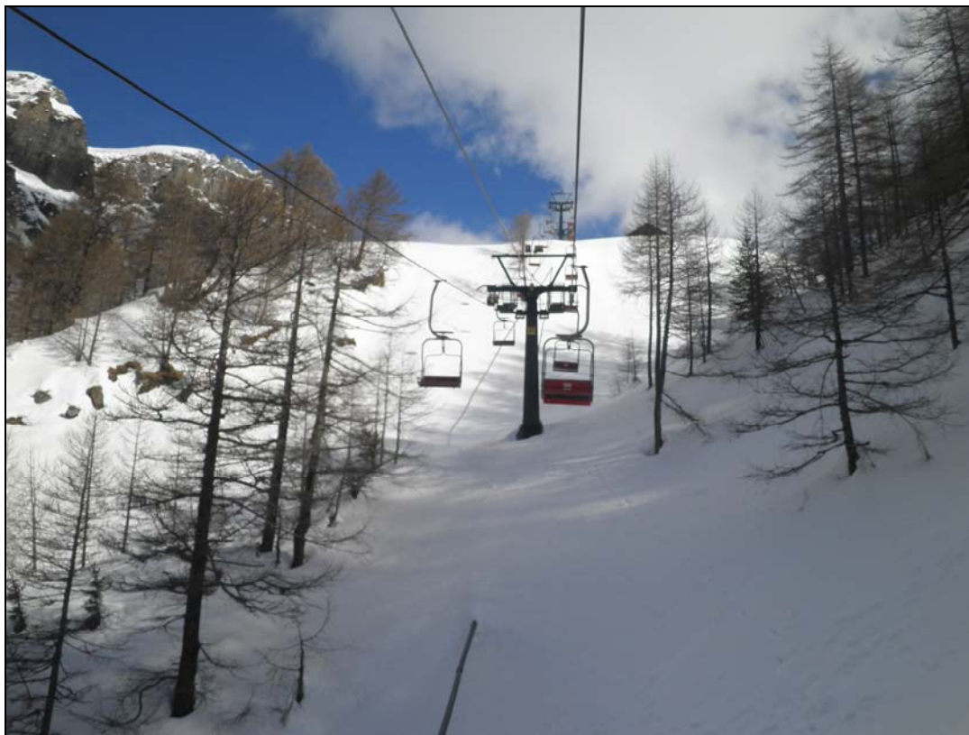
Figura 4 Sostegni (da rimuovere) seggiovia “Casa Rossa – Alpe Ciamporino”
