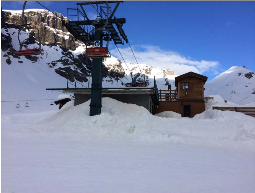
Figura 2 Stazione di monte (da rimuovere) seggiovia “Casa Rossa – Alpe Ciamporino”
