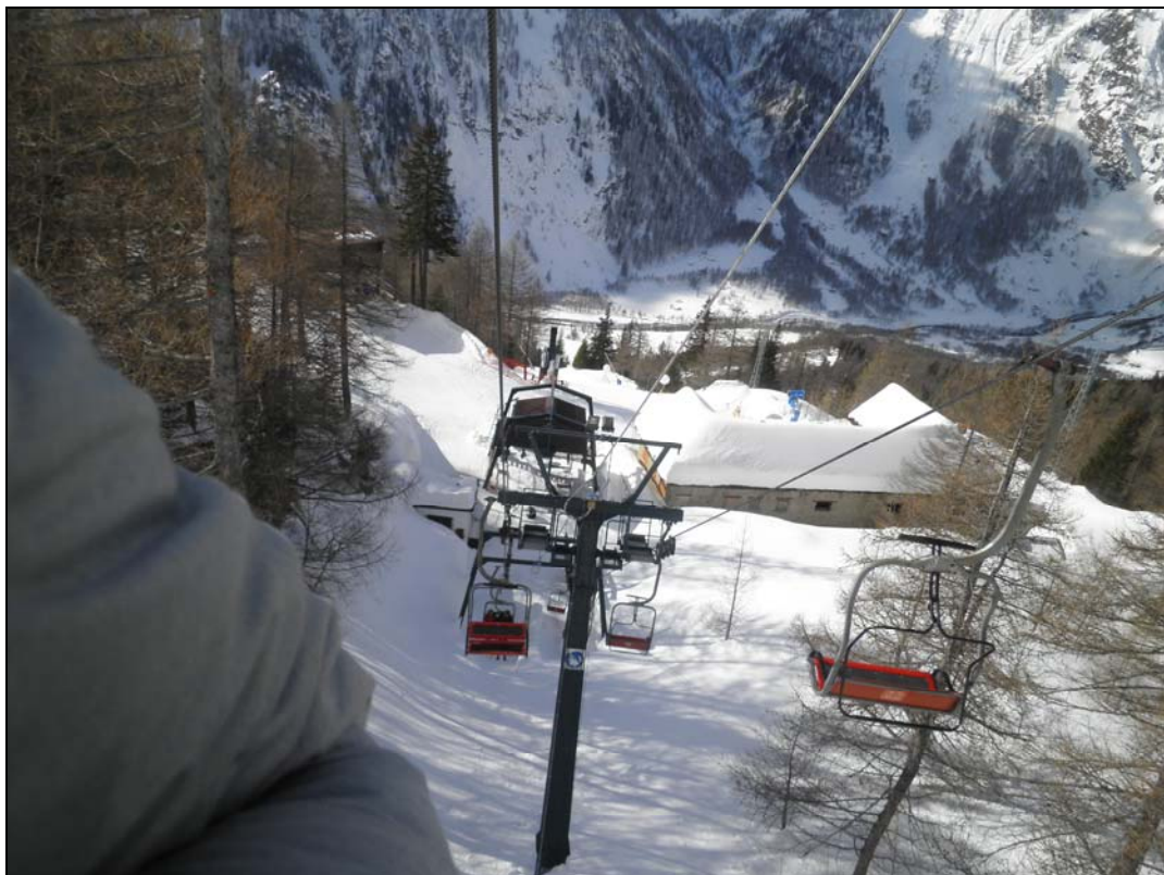
Figura 3 Stazione di valle (da rimuovere) seggiovia “Casa Rossa – Alpe Ciamporino”
